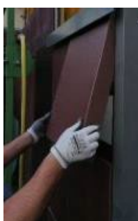
5. Dépose de la cassette endommagée
