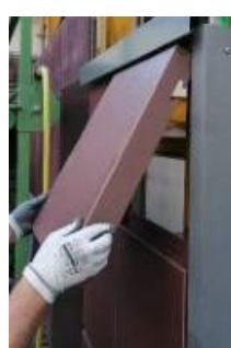
1. Cassettes installées. 2. Casette bloquée en partie basse (coulisseau) remonté pour permettre de retirer la cassette 3. déblocage de l'étrier (coulisseau) 4. Etrier
