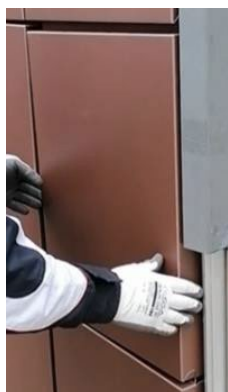
8. Déposé d'une cassette endommagée sous une autre cassette
