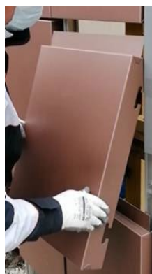
8. Déposé d'une cassette endommagée sous une autre cassette
