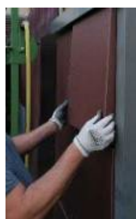
5. Dépose de la cassette endommagée
