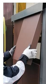
7. Pose de la cassette de remplacement
