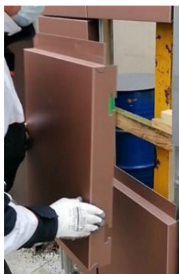
7. Pose de la cassette de remplacement
