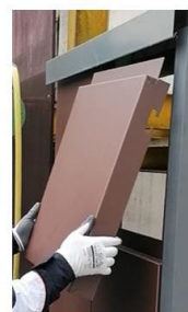
7. Pose de la cassette de remplacement
