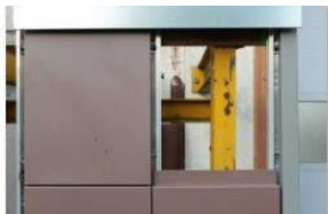
6. Casette déposée
