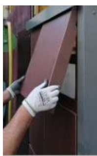
1. Cassettes installées. 2. Casette bloquée en partie basse (coulisseau) remonté pour permettre de retirer la cassette 3. déblocage de l'étrier (coulisseau) 4. Etrier
