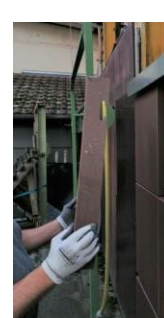
1. Cassettes installées. 2. Casette bloquée en partie basse (coulisseau) remonté pour permettre de retirer la cassette 3. déblocage de l'étrier (coulisseau) 4. Etrier
