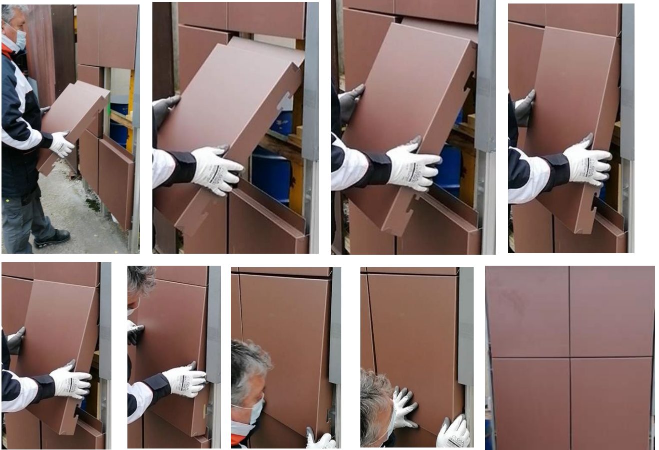
9. Repose d'une cassette sous une autre cassette
